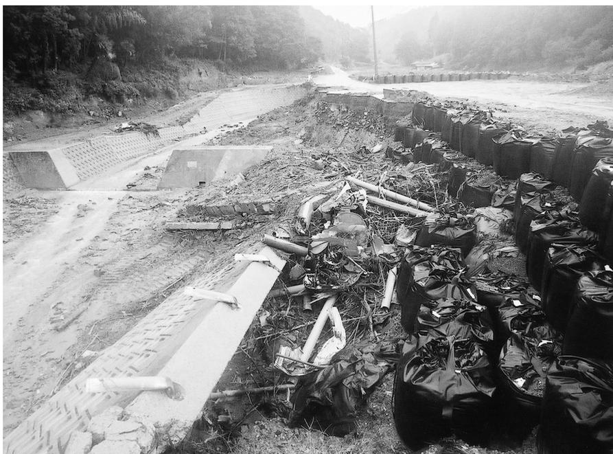
二次、三次の崩壊を防ぐため、大型の土のうを積んだ川の護岸
